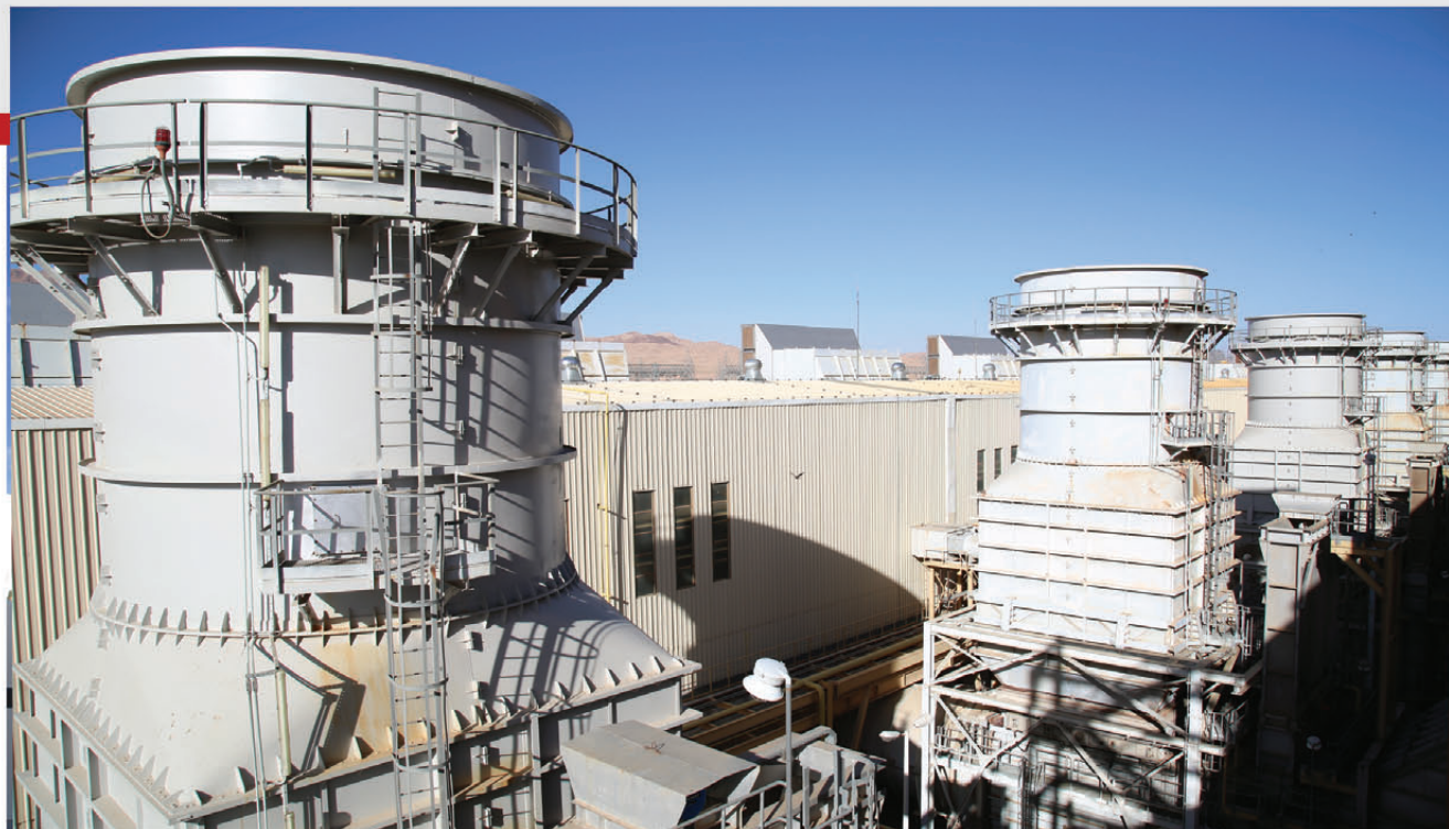
▲ سیستم اگزوز (Exhaust system) :
