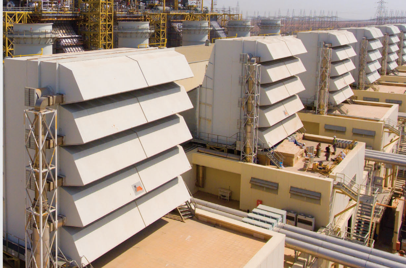
▲ سیستم هوای ورودی (Air intake) :
